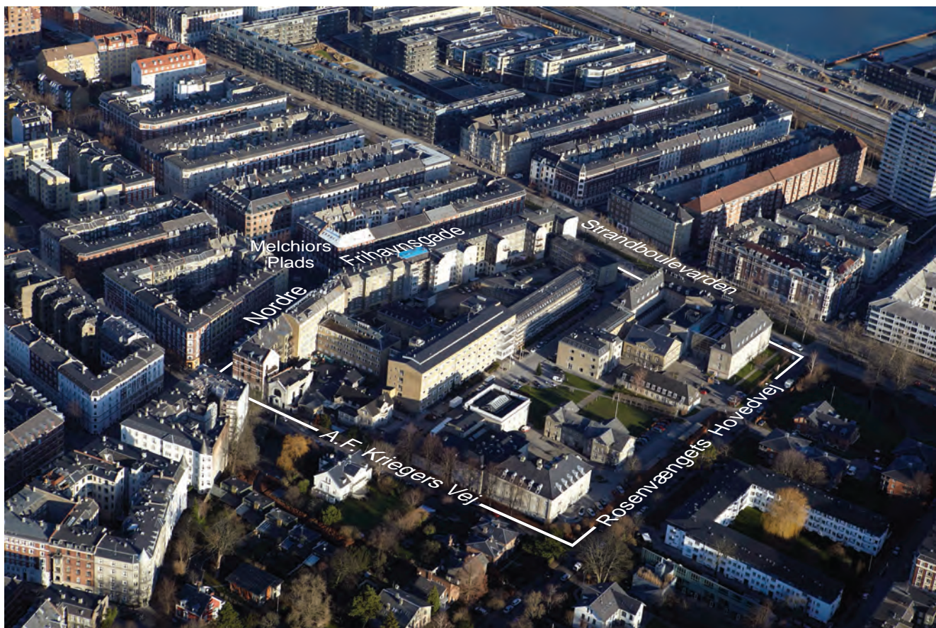
Luftfoto af området set mod nordøst – det aktuelle lokalplanområde er indrammet med hvidt (JW Luftfoto, januar 2012)
