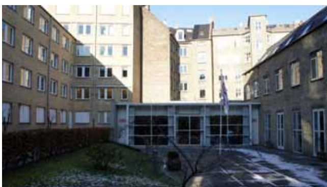
Den eksisterende kantine for Kræftens Bekæmpelse. I baggrunden ses bagsiden af bebyggelsen mod Nordre Frihavsgade.
