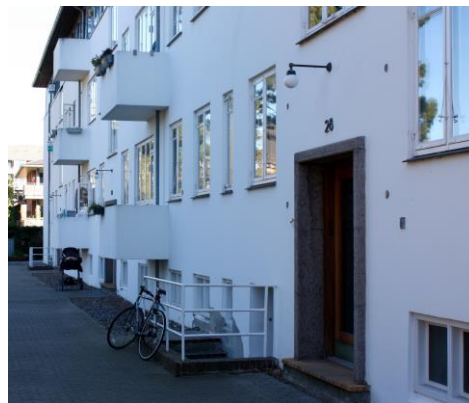
↑ Den internationalt prægede funktionalisme har lyse, pudsede facader og lav taghældning. Rosenvængets Hovedvej 18-42.
